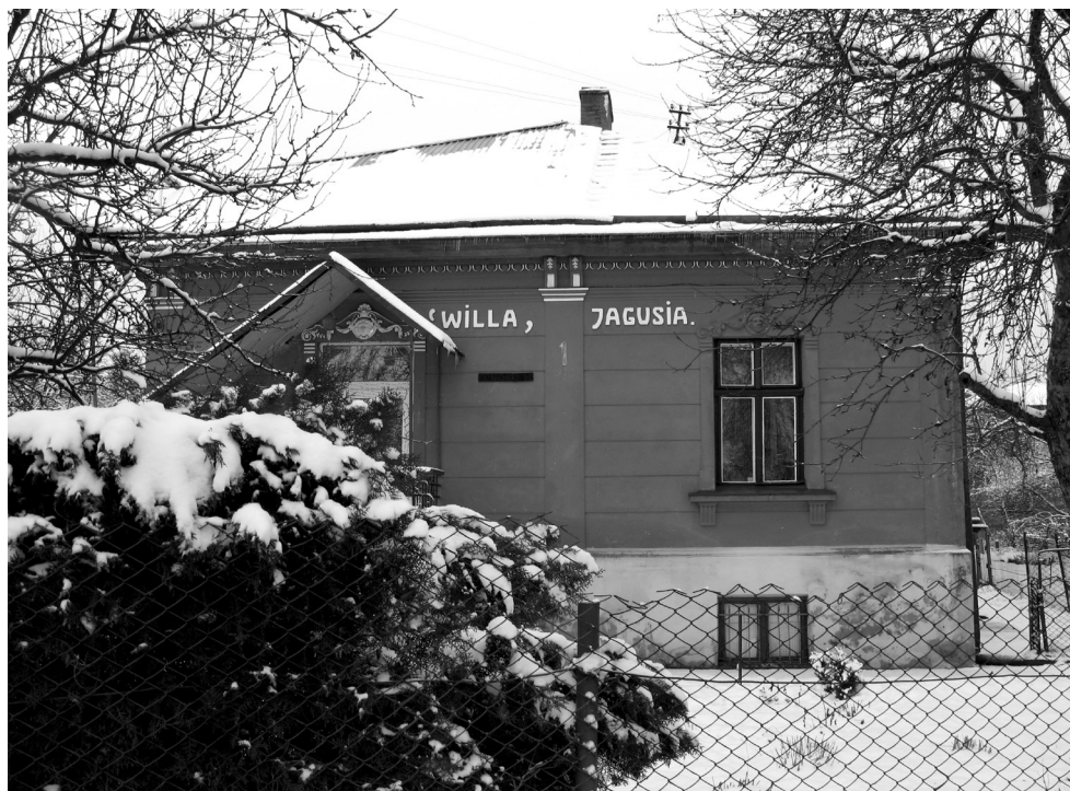
Іл. 5. Вілла «Ягуся» в 2010 році. На знімку видно, що в одній частині будинку було збережено стару віконну раму, натомість у другій частині мешканці встановили пластикове вікно й дашок. Фото авторки.
