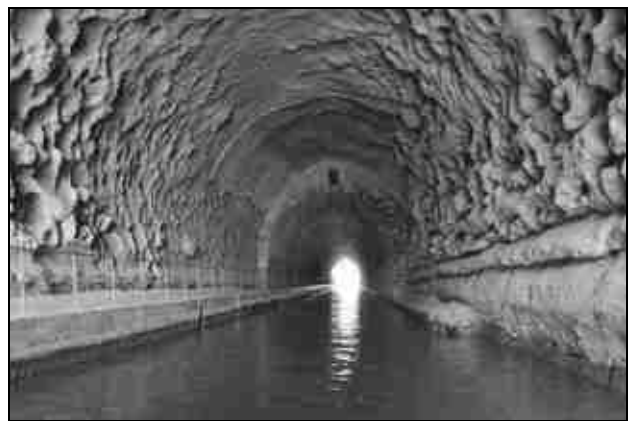
Рис. 105. Malpas Tunnel (Франція)
