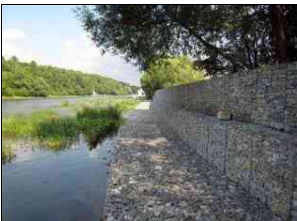
Рис. 95. Варіанти укріплення берегів: габіони (ліворуч) і георешітки
