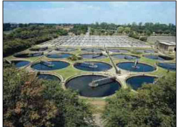
Рис. 73. Станція очистки води перед подачею у Лондонську кільцеву магістраль
