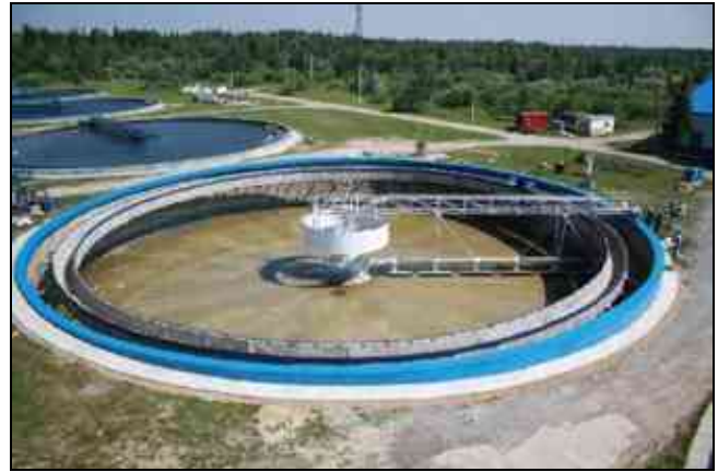
Рис. 77. Радіальні вторинні відстійники
