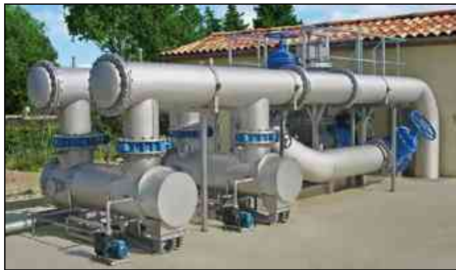
Рис. 79. Установка ультрафіолетового знезараження води
