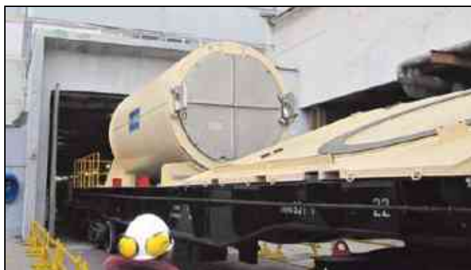
Рис. 24. Доставка першого контейнеру HI-TRAC на Рівненську АЕС
