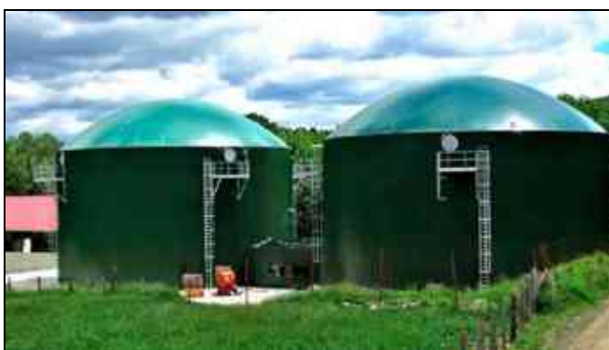
Рис. 41. Біогазова станція на відходах
