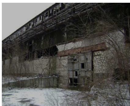
5-3. Споруда 1, склад уранової сировини Building 1, composition of uranium raw materials
