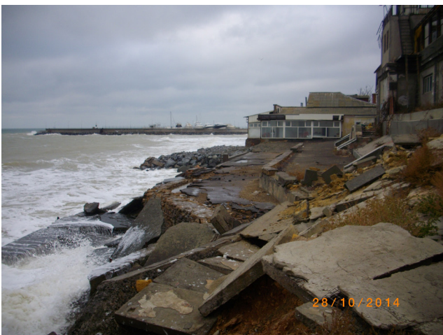
Рис. 2. Ця залізобетонна та кам'яна конструкція не тільки не захистила активний кліф від абразії (швидкість відступу 1,2 м/рік). Нерозуміння прибережно-морських процесів з боку проектувальників вивело ділянку берегу із купального та бальнеологічного користування на березі Чорного моря. Фото: Ю. Д. Шуйського, 28 жовтня 2014 р.
