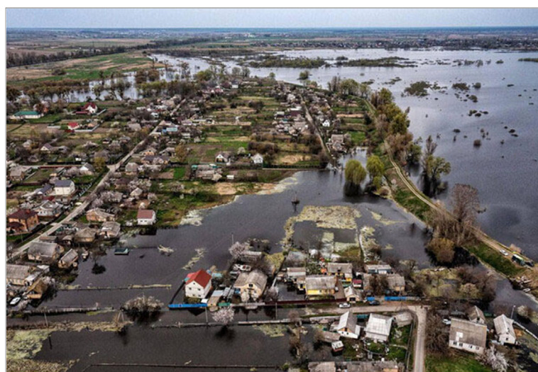
Рис. 7. Селище Демидів. У результаті пошкодження дамби частково затоплено близько 50 приватних садиб. 28.06.2023 р. Фото The New York Times.
