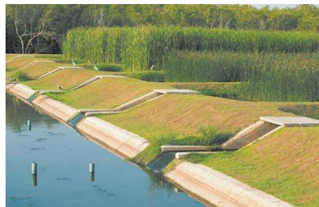
**Мал. 106.2.** Очищення стоків із використанням біоплато
