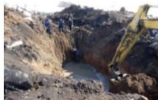
Іл. 75.9 Викопування водовідвідної канами
