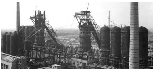
Загальний вигляд будівництва доменної печі Запорізького металургійного комбінату, 1931 р.
