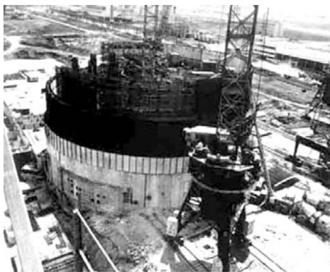
Монтажні роботи на реакторному відділенні Південноукраїнської АЕС
