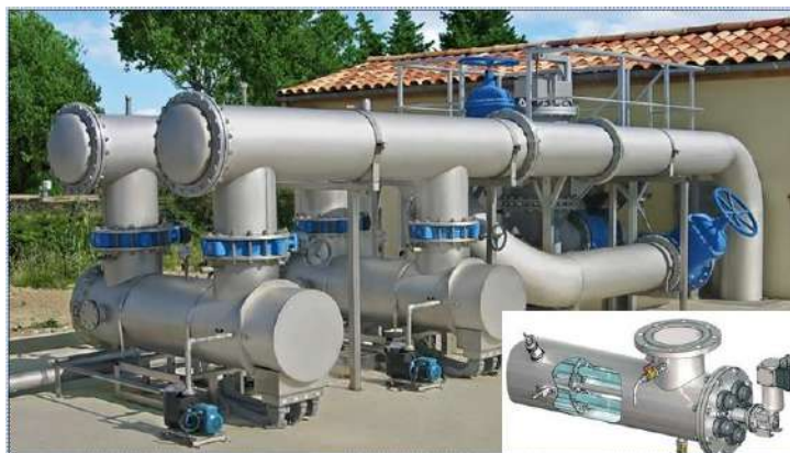
Рис. 63. Установка УФ знезараження води
