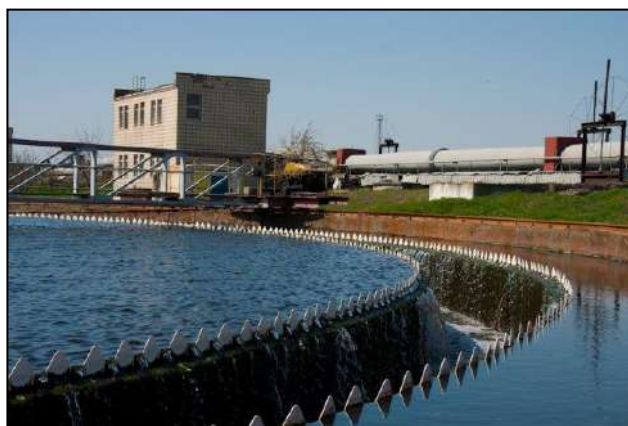
Рис. 61. Вторинний відстійник Бортницької станції аерації
